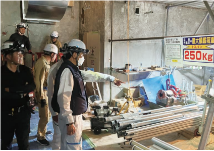
安全パトロールの様子
