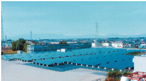
ぺんぎんメガソーラー発電所(埼玉県本庄市)
