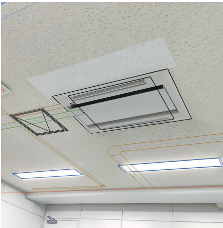
図面可視化による施工イメージ
