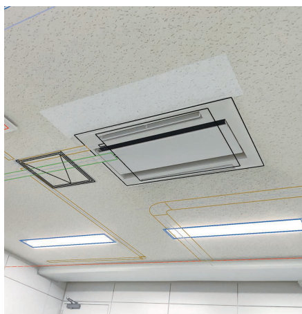
図面可視化による施工イメージ
