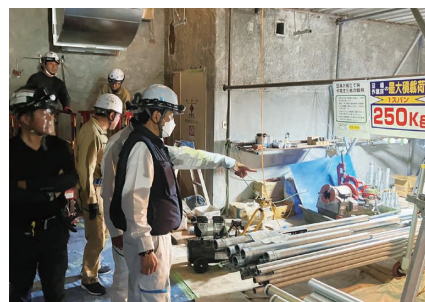
安全パトロールの様子
