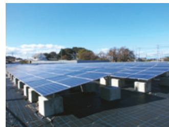
ぺんぎんメガソーラー発電所三号機
