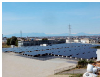
ぺんぎんメガソーラー発電所一号機
