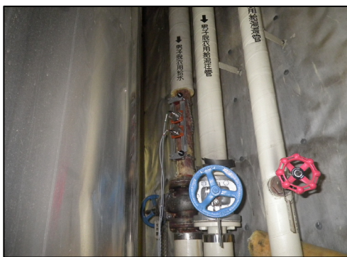
配管内流量計測
