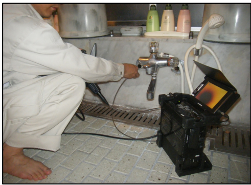
配管内内視鏡調査
