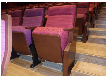
置換空調システム （座席下吹出口）
