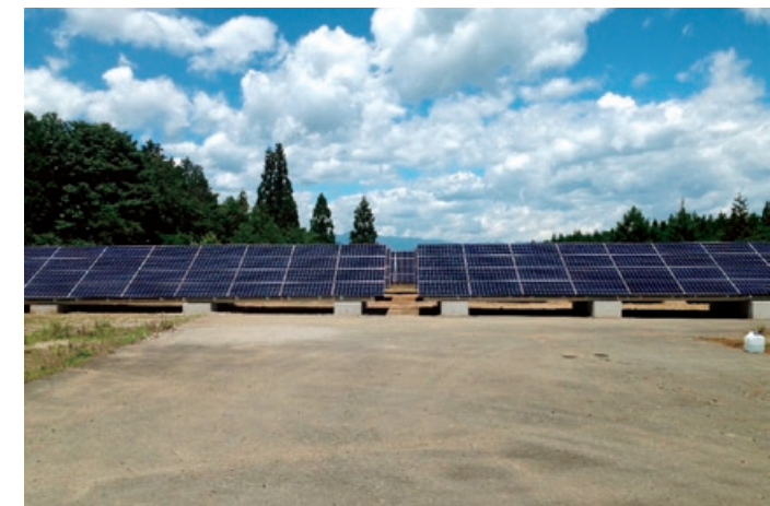
太陽光発電所 施工事例 2013年7月、群馬県に設置。発電規模49.9kW
