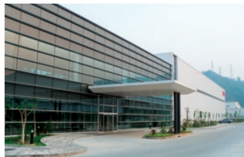
スタンレー電気広州工場
